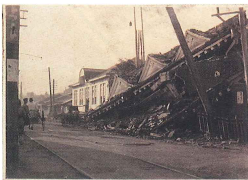
▲ 関東大震災直後の様子。 この写真は現在のガス灯通り。倒壊した建物と倒壊を免れた建物がありましたが、多くは火災で焼失しました。
